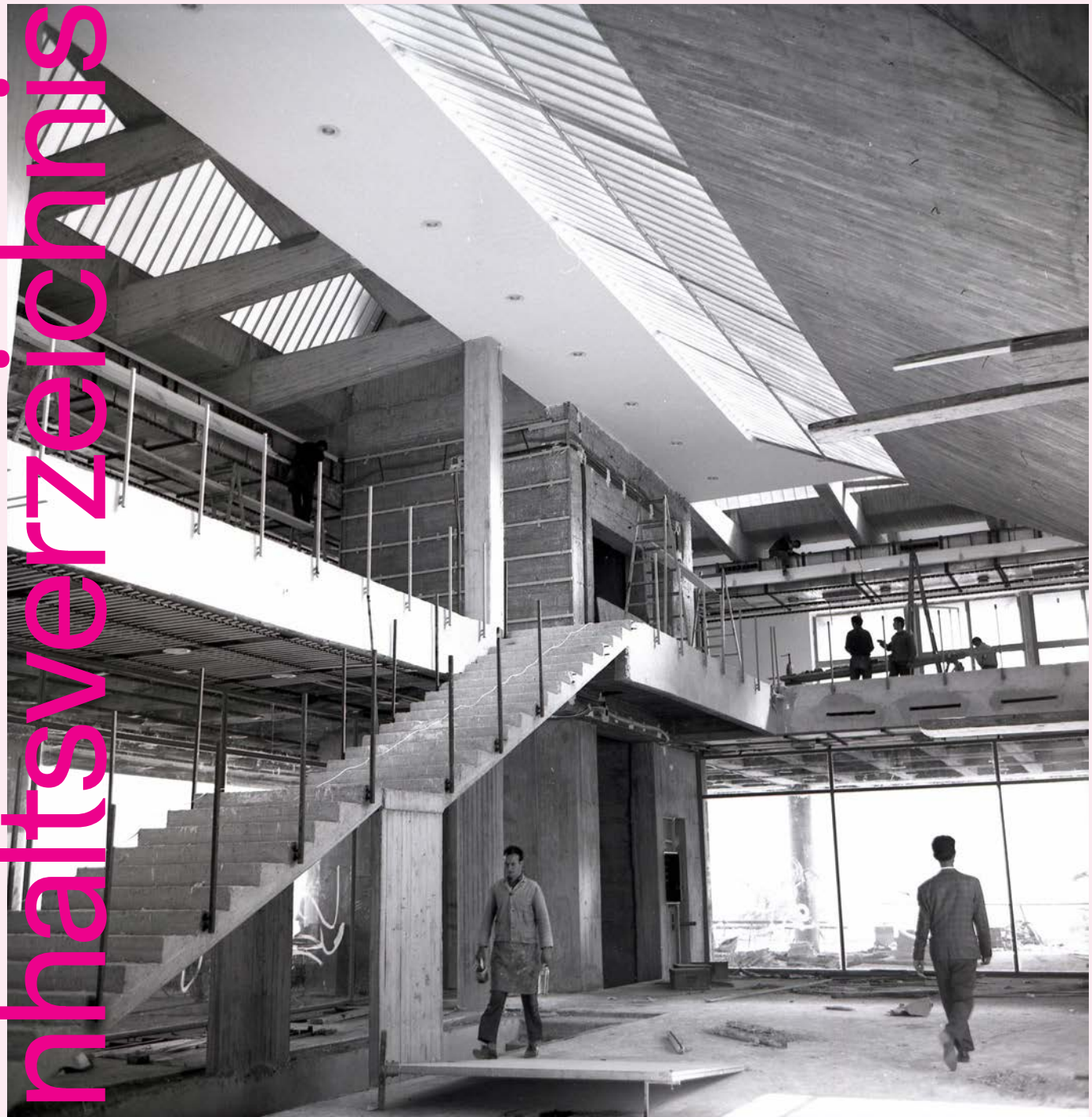
Innenausbau des MoCA Skopje, 1969/1970 • COURTESY MOCA SKOPJE
